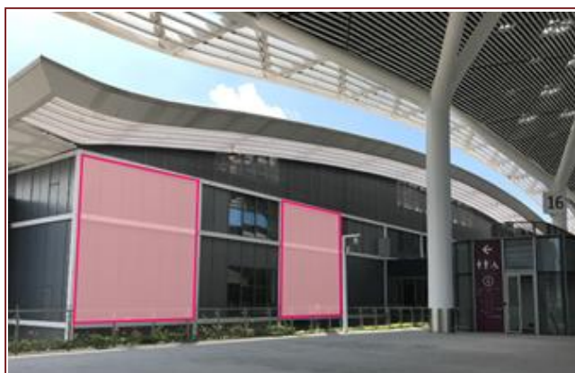
B03(b) 横幅 - 馆外立面: 靠近中央廊道(上)
